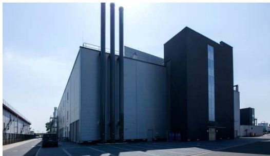
DC Campus Frankfurt 1 60.000 m 2 RZ-Fläche, weitere 6.000 m 2 geplant
