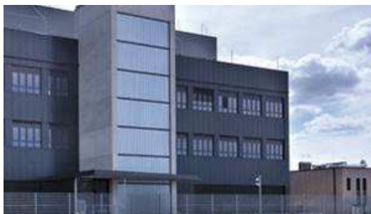
DC Frankfurt 3 9.200 m 2 RZ-Fläche, weitere 4.200 m 2 geplant
